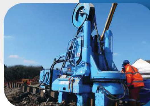
Установка статического вдавливания
